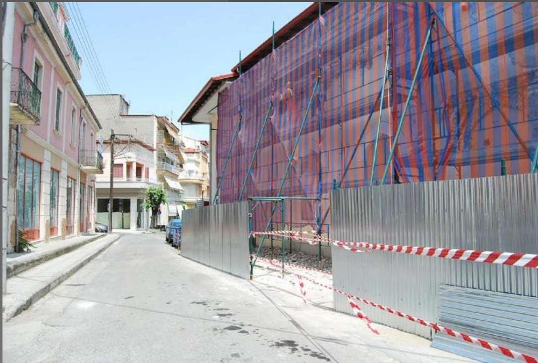
Έργο υπό επισκευή
