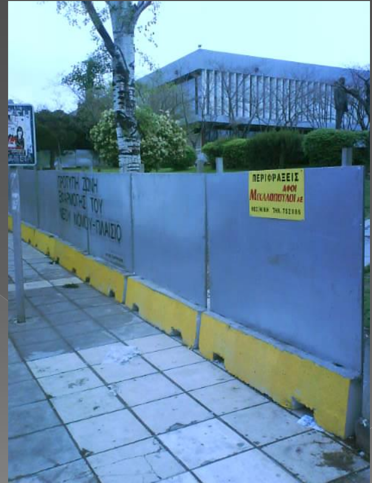
Έργο υπό ανέγερση
