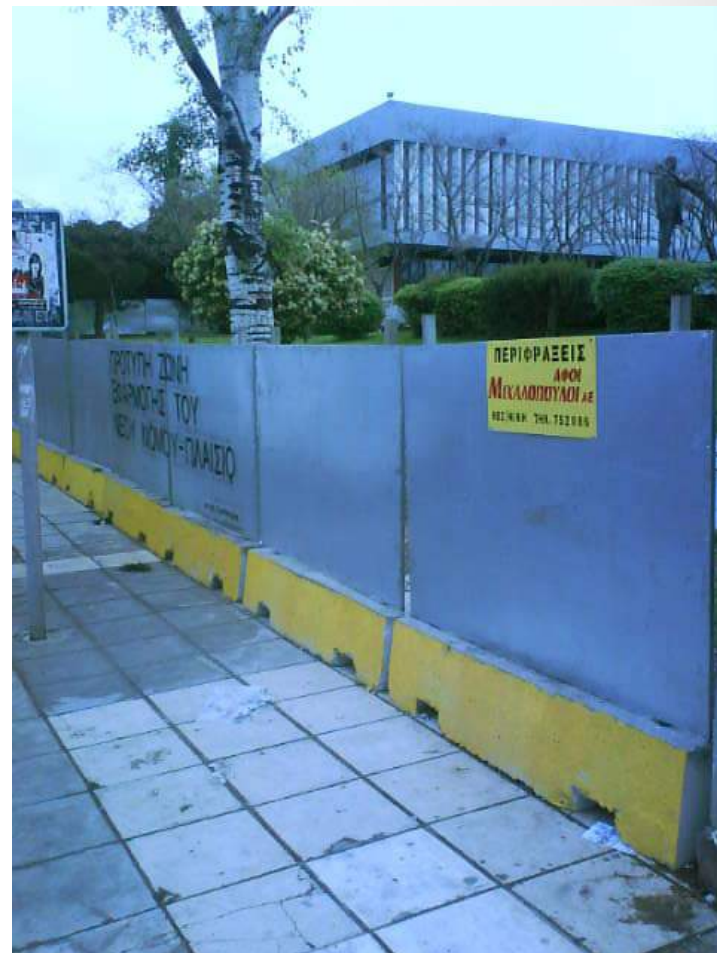
Έργο υπό ανέγερση
