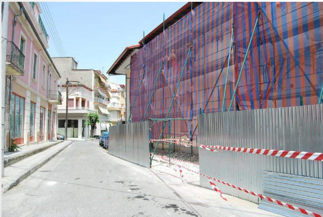
Έργο υπό επισκευή
