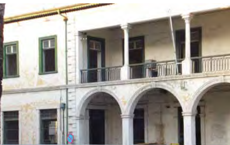
Άποψη του κτιρίου πριν από την έναρξη των εργασιών
